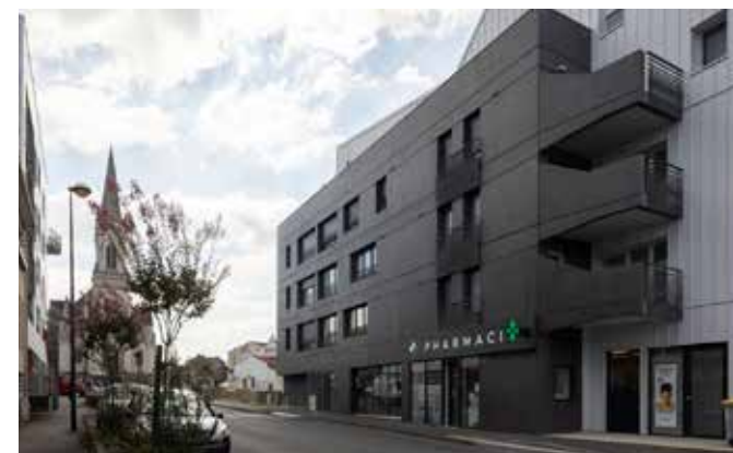
Habitat accompagné « Carré Daviais » à Rezé
